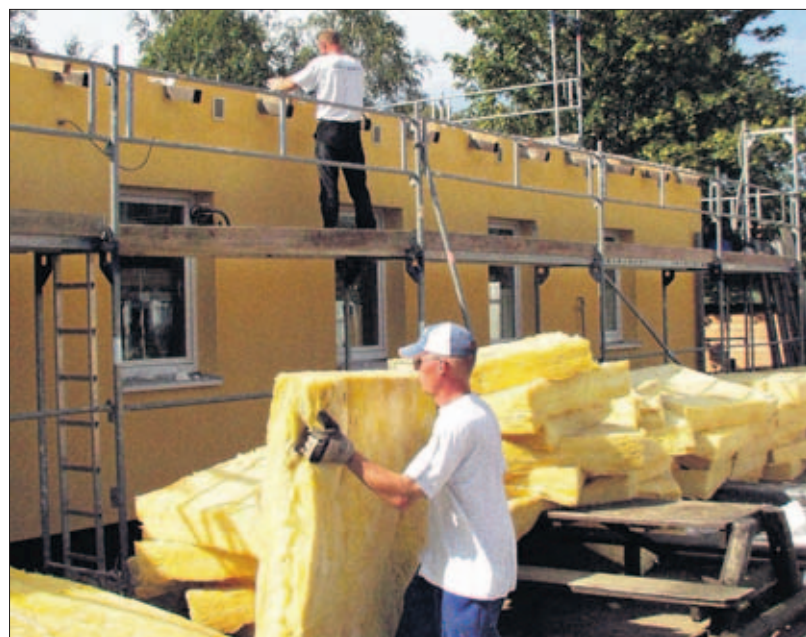
Die Kirch Mulsower Dachdecker-Firma Nerstheimer deckt das Dach der Bummi-Kita neu. Vernünftige Dämmung kommt rauf, anschließend ein Blechdach. Einige Wochen werden die Arbeiten dauern. Fotos (2): Renate Peter
